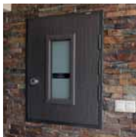
Ochrana elektroměru, bezpečnostní třída 3
