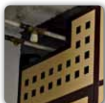
Přizpůsobení rozvodům ve sklepě
