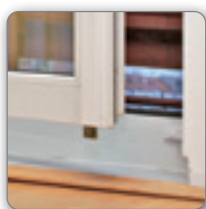
Príklad uzamknutia balkónových dverí, spodný protikus
