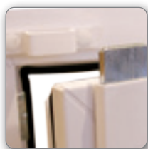
Uzamykací mechanizmus okna, horný protikus
